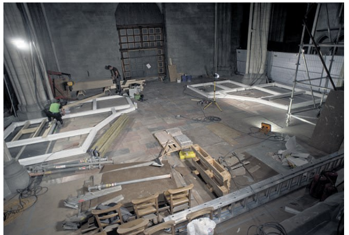
Alt klart: Steinmeyerorgelet plasseres på nye stålrammer på det forsterkede gulvet i vestskipet i Nidarosdomen. Foto: NILS H. TOLDNES
